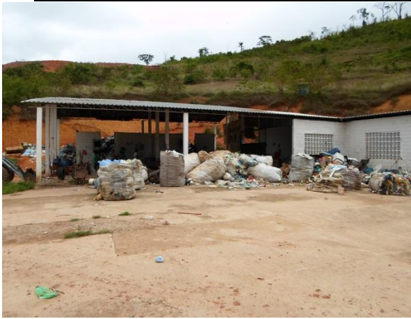
Figura 20. Vista da UTCRSU-Usina de Triagem e Compostagem de Resíduos Sólidos Urbanos Fonte: Visita técnica (28/11/2013).
