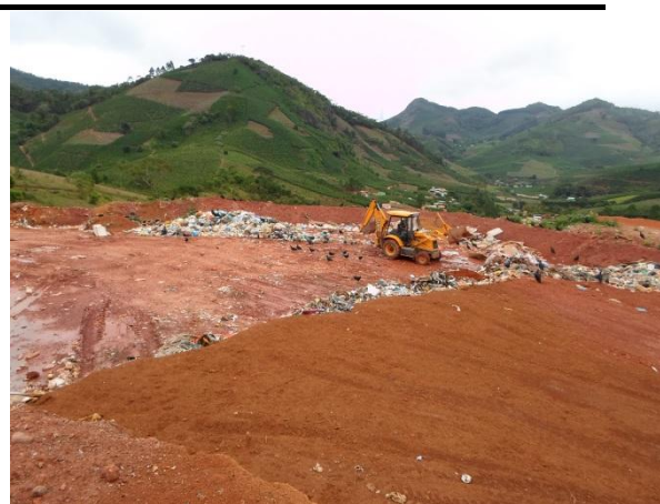
Figura 59. Aterro de rejeitos de Manhumirim.
