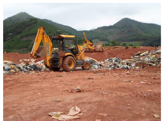
Figura 57. Retro escavadeira utilizada para o transporte de resíduos e aterro.
