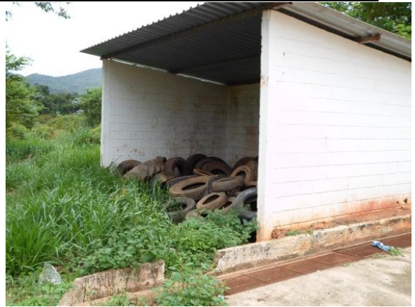
Figura 47. Depósito de pneus.
