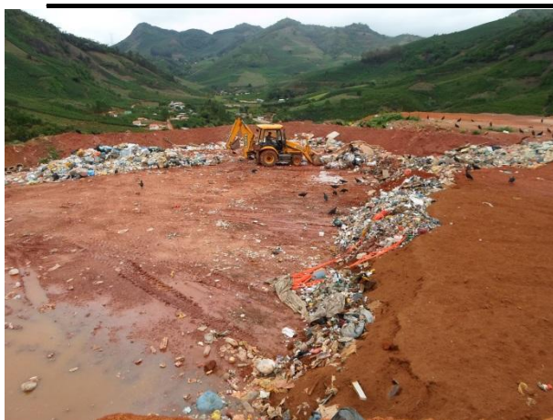
Figura 58. Aterro de rejeitos de Manhumirim.
