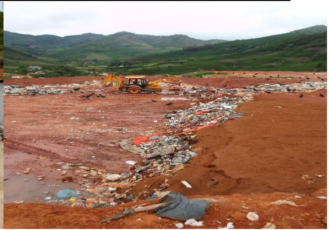
Figura 21. Aterro Controlado de Resíduos Fonte: Visita técnica (28/11/2013).
